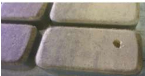
Рисунок 4.26. Подрыв на плите бетонной тротуарной
